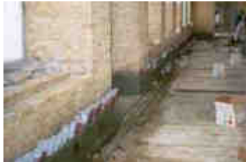
Torpedowerkstatt. Diese Wände sind fast 1 Meter dick.
