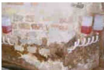
KÖSTER CRISIN® 76 zog von dem äußersten Loch rechts in die Mauerfassade.
