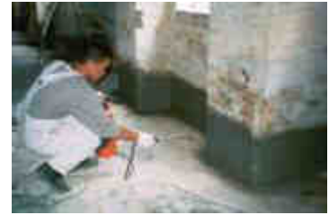
KÖSTER CRISIN® 76 ist injiziert und KÖSTER NB I grau wird aufgetragen.
