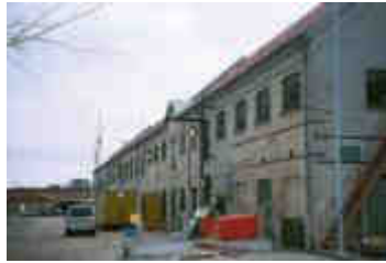
Gebäude 47. Der Technikraum liegt vorne im Bild, die Torpedowerkstatt auf der anderen Seite.
