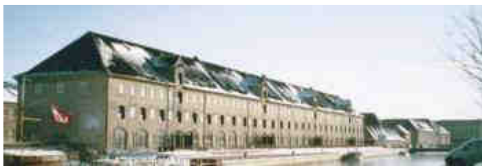
Südliches Magazin nach dem Umbau zu Wohnungen.
