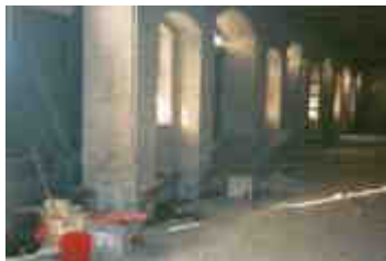
Mauersektion des Vollskalaversuches.
